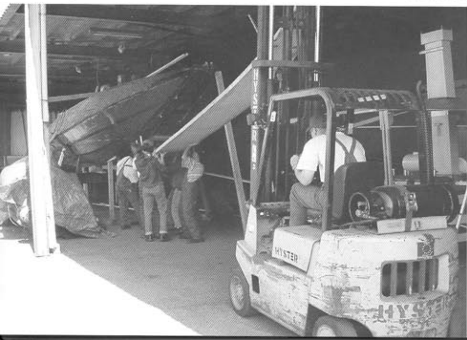
Aanbrengen eerste vlakdeel.
